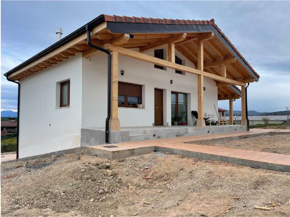
IMAGEN FACHADA LATERAL DOLBI 82 H3
