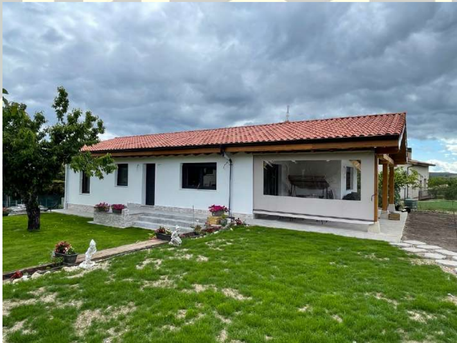
IMAGEN FACHADA LATERAL DOLBI 90 H3
